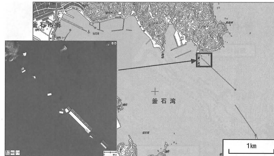
図3 釜石湾口防波堤の津波による損傷
